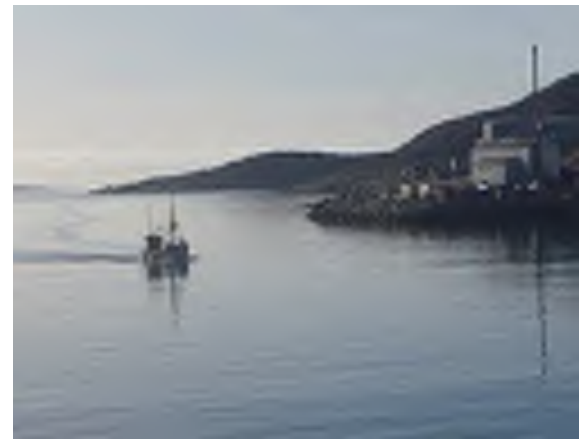
Forbrændings anlæg i Qaqortoq
